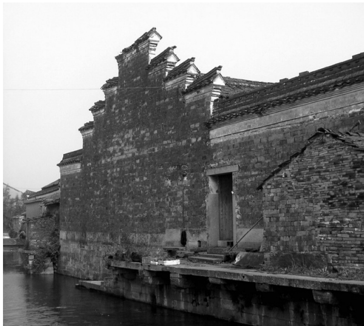
宁波鄞州区走马塘古镇民居 瓦片墙实例
